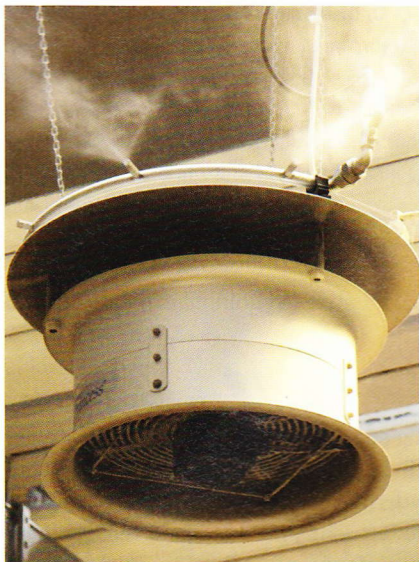
Vanddamp sprayeres ud i papirlageret for at holde fugtigheden konstant.
