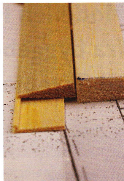
Bagkanten på rør klodses op.
