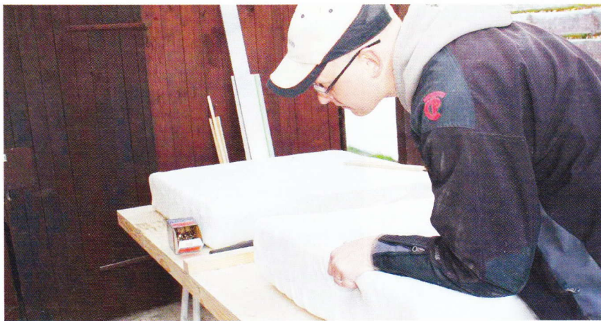
Madrasserne monteres under udtrækspladen.
