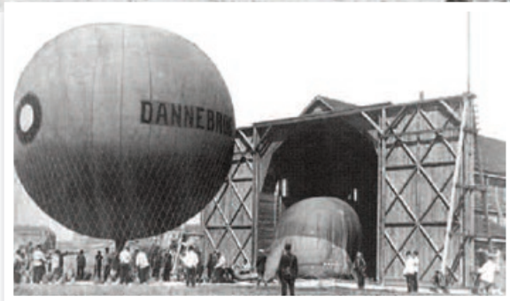
Den store observationsballon trækkes i hangar efter en øvelse. Hangaren fungerer i dag som ridehus og skal nu fredes.
