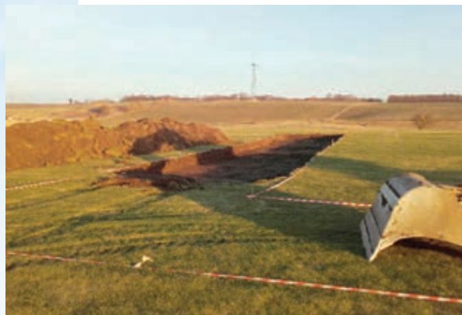
Opmærkning gjort og den første udgravning er i gang ...
