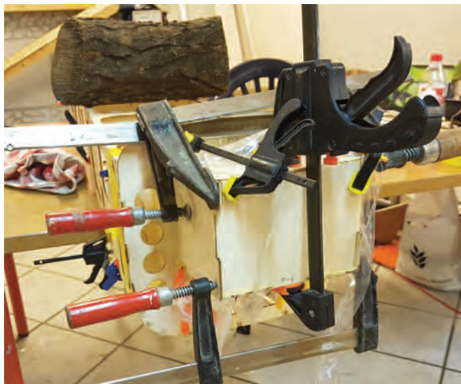
Her er jeg ved at bygge brændskottet på kroppen. Der hvor min DLA 112cc boxermotor skal sidde.
