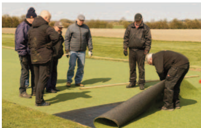
At lægge kunstgræs ligner på flere punkter at lægge tæppe. Der skal både limes, rulles og sømmes ...
