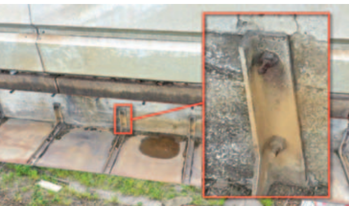
Skærmtag monteret på bro
