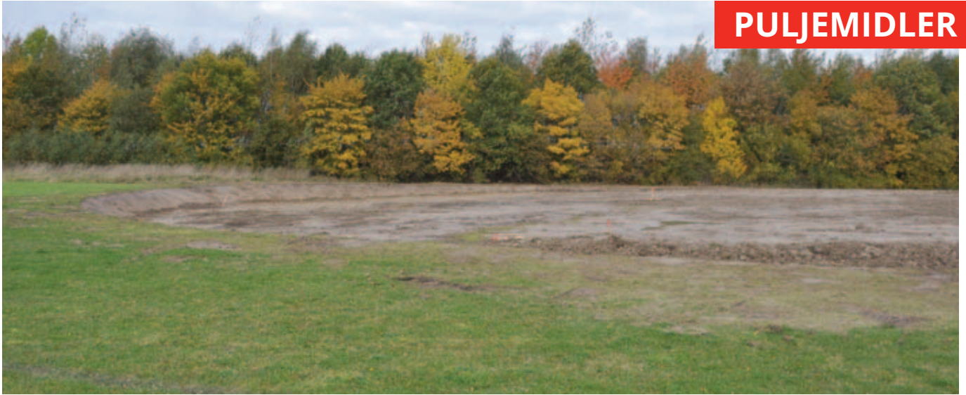
Færdigt terrænarbejde. Nu skal jorden bare sætte sig, så vi kan støbe til foråret
