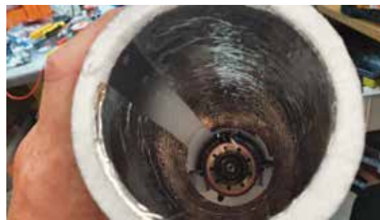
Indvendig forring med alutape for at beskytte skummen mod varme
